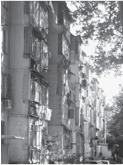
写真 42 住戸毎にそれぞれの窓枠をもつ集団住宅の様子
