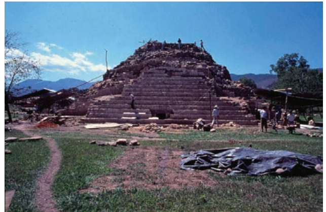
Foto 2. La Estructura 1 en proceso de excavación y restauración (1992)
