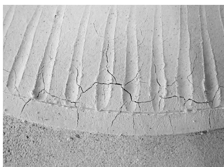
石灰クリームの分量を増やした実験（多数の亀裂が入っている）
