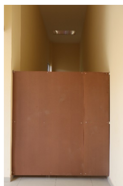
通路を板で仕切ってサロンから 金沢大学オフィスへ通行できないように対処 (2020年8月)
